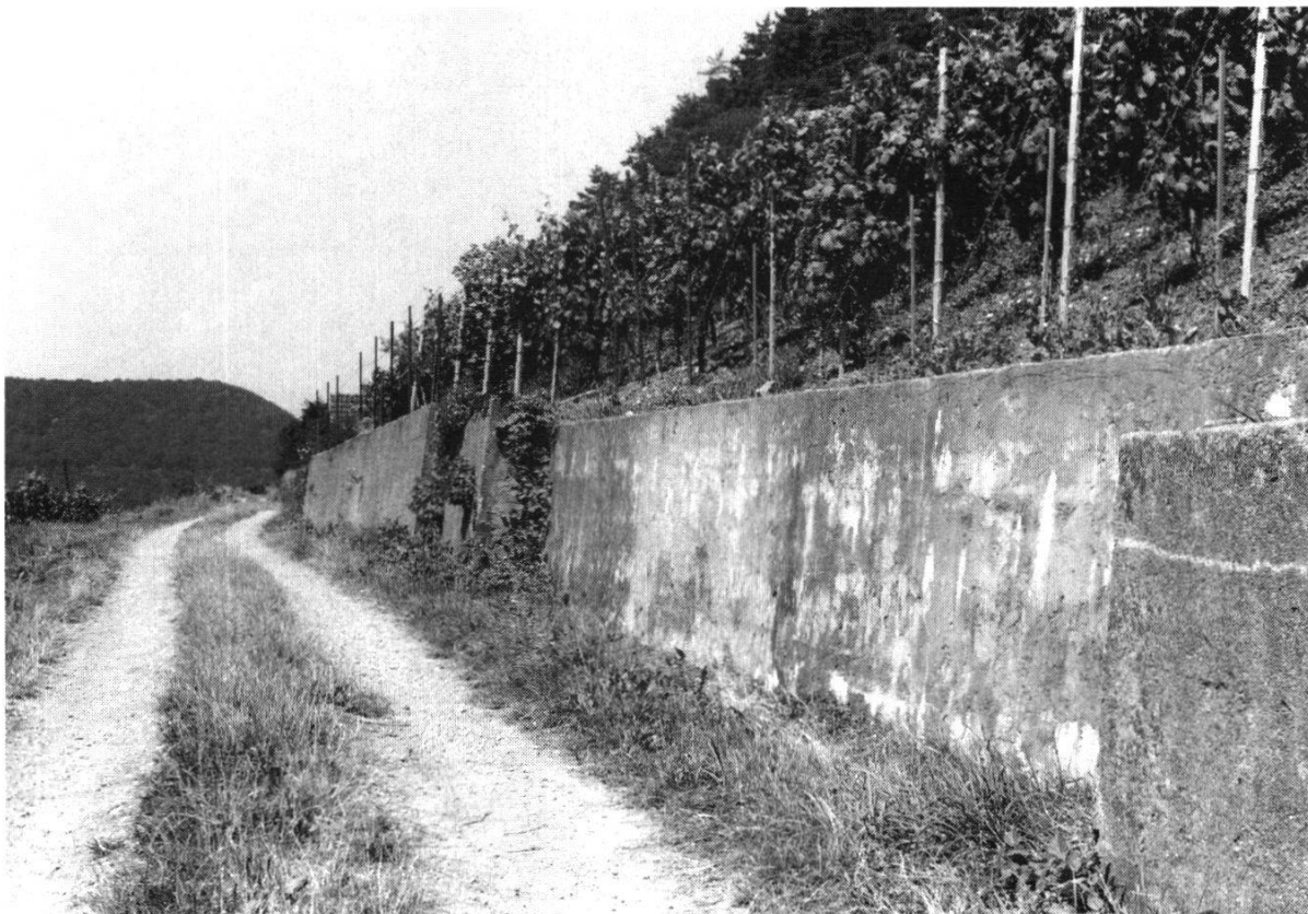
Abb.31: A: fugenreiche Natursteinmauer in einem Rebberg des Tafeljura. Versteck und Besonnungsplatz vieler Reptilienarten, u. a. der Mauereidechse ( P. muralis ). B: «langweilige» Betonstützmauer, ohne Versteckmöglichkeiten für Reptilien.
