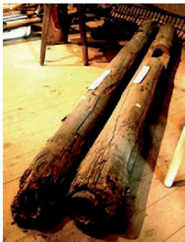
Abb. 10. Wasserdeichel (Dükkel) mit Röhrenbüchsen zur wasserdichten Verbindung, Ortsmuseum Unterentfelden (Staufferhaus) http://www.wirrizunft.ch/pages/Bachgeschichte.htm
