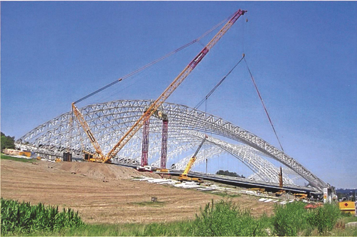
Abb. 13: Bau der Infrastruktur: Aufrichten der Bogentragwerke für das stützenfreie Hallendach über der auszugrabenden Sondermülldeponie 2006–2007 (Foto: J. Hochreuter, 2007, SMDK-Archiv)
