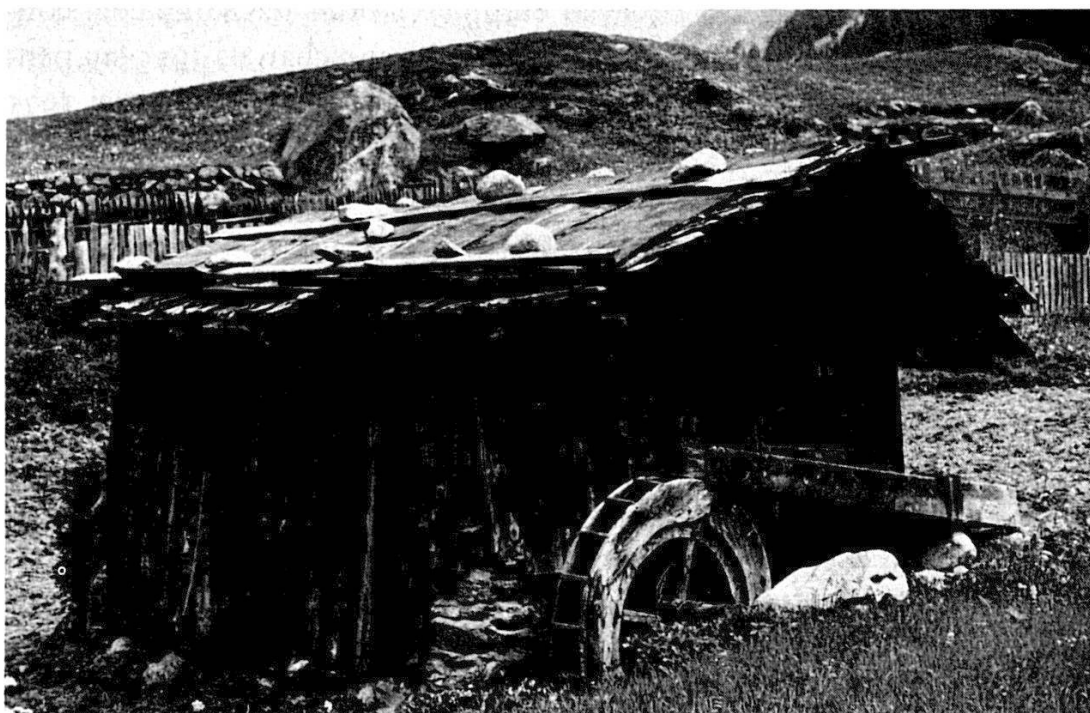
Il fallun da Sep Truaisch a Fuorns. La canal pusada silla rod'aulta mantegn la paretta. Foto da Paul Caminada, Thalwil.
