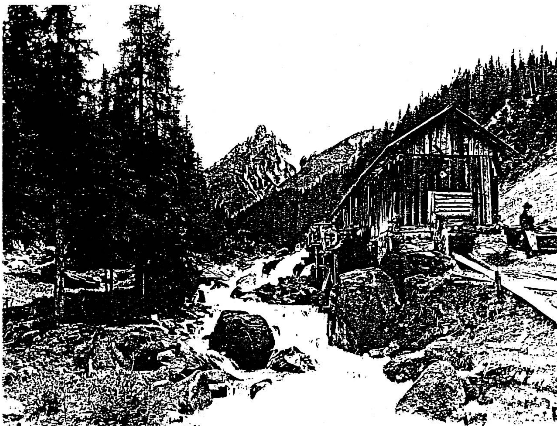
La resgia da Plauna cun l'auadottel
