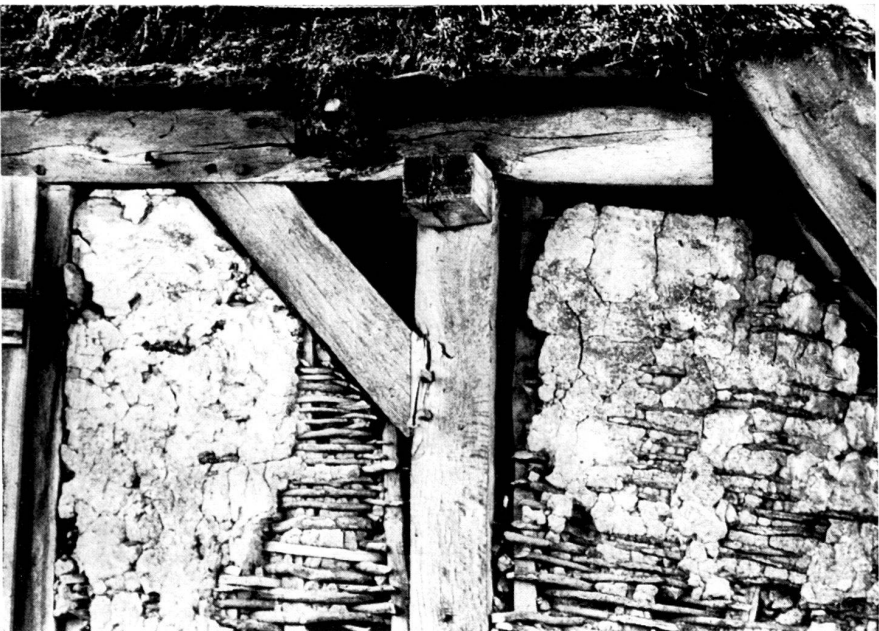
Alter Stall bei Undeloh. Felderausfachung mit Weidengeflecht und Lehmewurf. Bild: P. Bolliger Vieille écurie à Undeloh. Délimitation des champs au moyen de treillis d'osier et de crépi de terre glaise. Photo: P. Bolliger Old shed near Undeloh. Infills with wattle work and clay coat. Photograph: P. Bolliger
