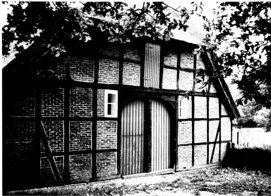
Felderausfachung mit Ziegelverbänden. Bild: U. Berchtold Encadrement des champs et assemblage de briques. Photo: U. Berchtold Infills with brickwork. Photograph: U. Berchtold
