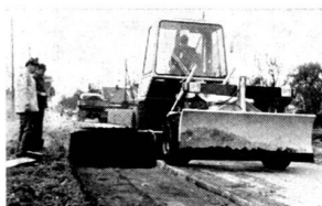
beim Bitumen-Einbau
