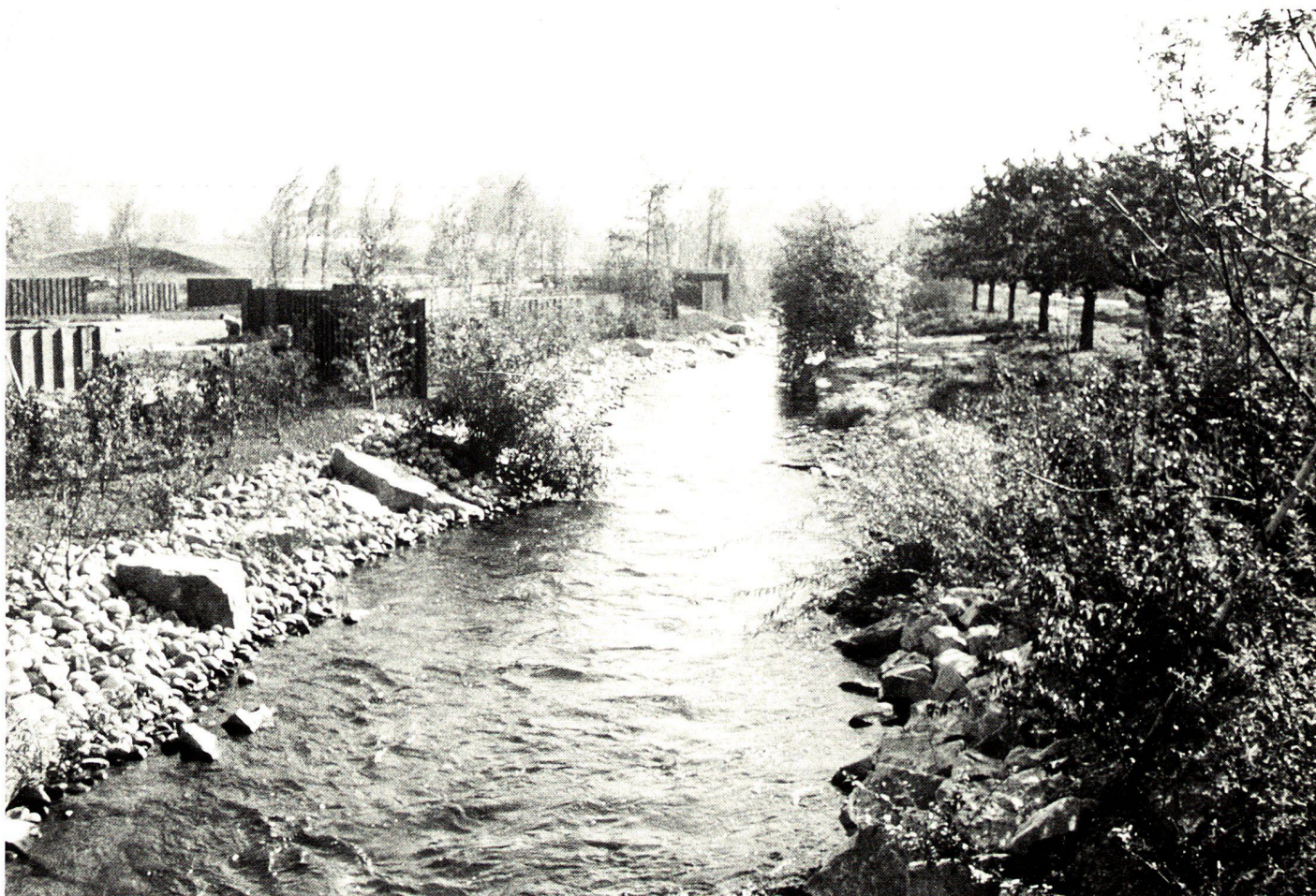
Ausbau des vormals gradlinigen Kanals zu einem naturnahen Gewässer.
