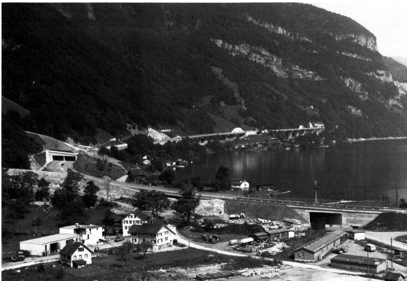
Die vom See zum Südportal des Seelisbergtunnels steigende Nationalstrasse ist in ihrer Lage bestimmt durch die Kreuzungen mit Lawinenzügen und Wildbächen und den steilen Felspartien. Die im Bild sichtbare Länge der Autobahn ist 2,1 km.
