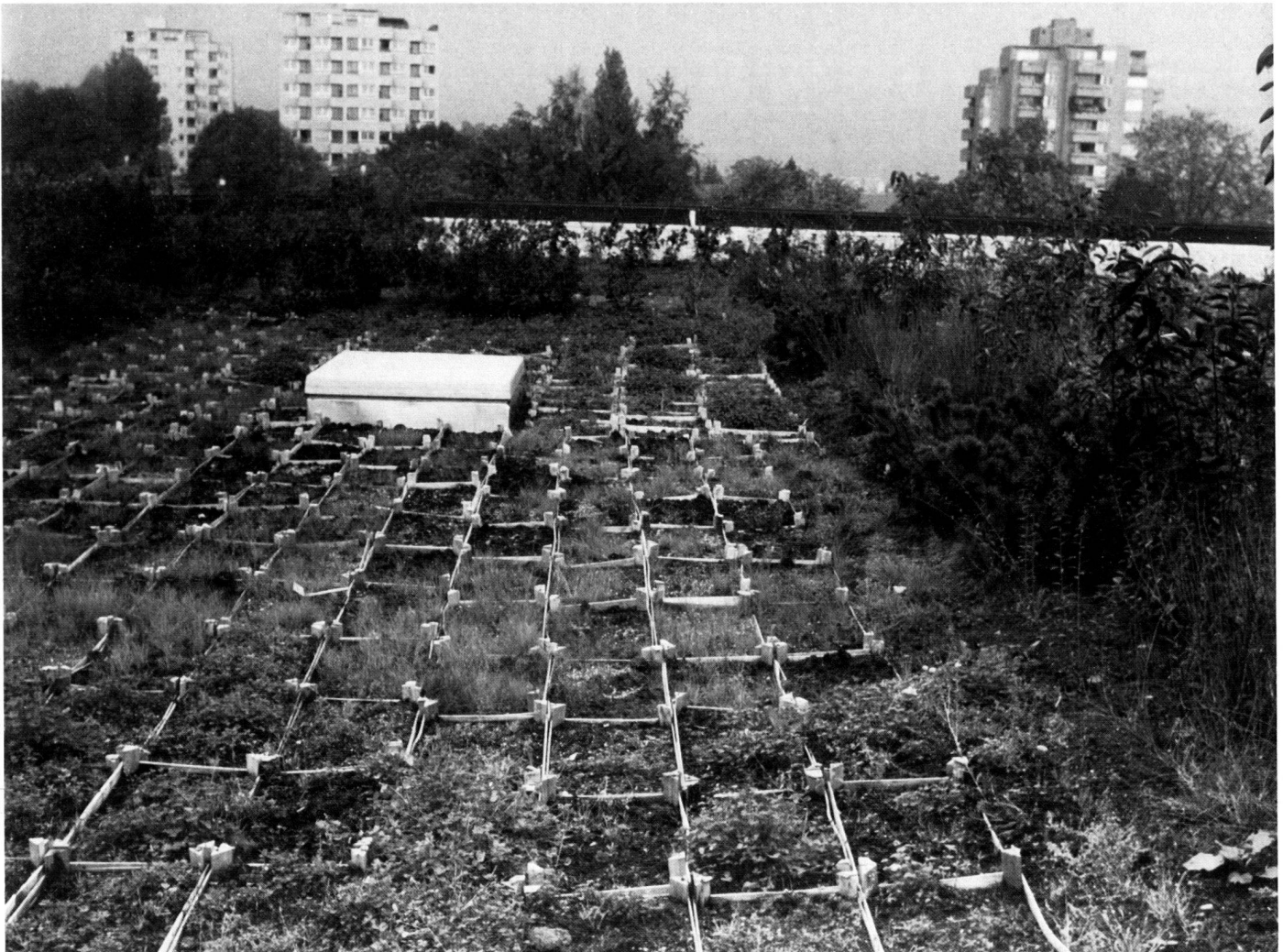
Rasterartige, schachbrettartige Verteilung der Dachbegrünung der in Holzkisten vorkultivierten Pflanzen.
