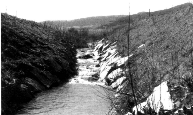
Links: Unterster Bachabschnitt mit steilen, hohen Böschungen. Tiefer Geländeeinschnitt zur Überwindung der Niederterrassenkante.
