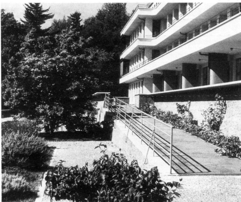
Links: Die neue Rampenanlage des Lory-Spitals.
