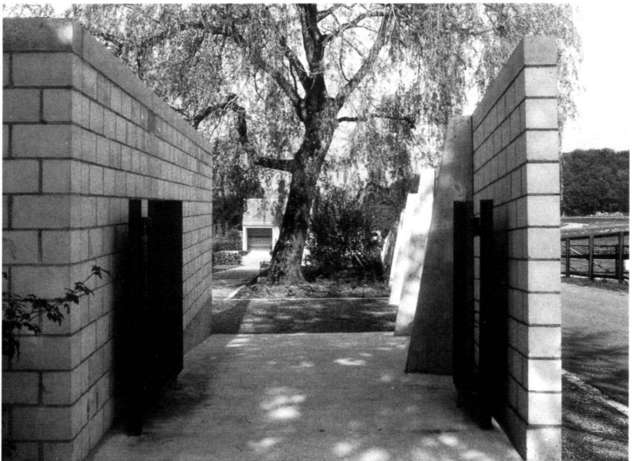
Haupteingang mit Trauerweide. Foto: F. Bochud, Zürich Entrée principale avec saule pleureur. Main entrance with weeping willow.
