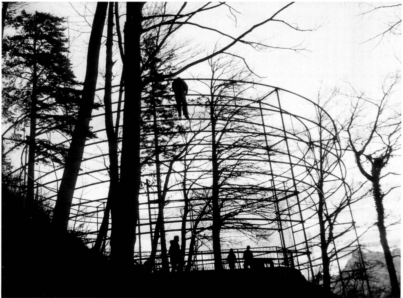
Bauarbeiten am Belvedere.
