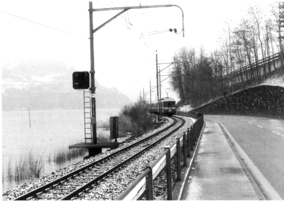
Abb. 2. Bestehende Situation Richtung Hergiswil, rechts oben Autobahntrasse.
