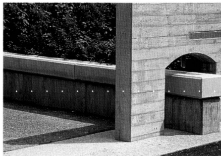
Im Fenster wird das Wasser an die Rinne übergeben. Das eingelegte Chromstahlband erinnert an die Wasserleitung im Beton.
