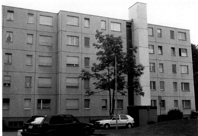
«Göhnerblock», Eingangsfassade im ursprünglichen Aspekt.
