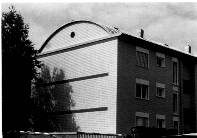
«Göhnerblock» im fast fertigen Zustand 1995.
