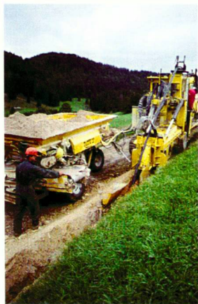
Verlegung der 20-kV-Leitungen im Naturpark Jura in Frankreich. Foto: BUWAL
