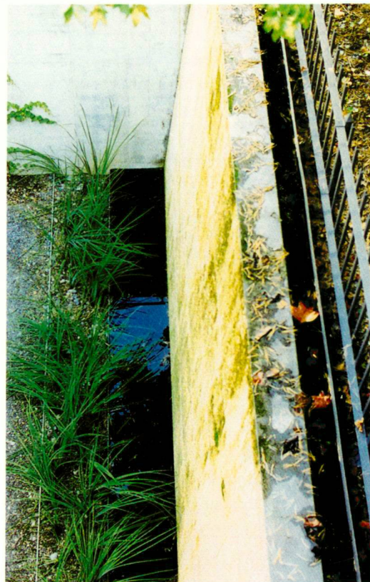
Rinne-Kante-Fläche – das System des Ab- und Überlaufens
