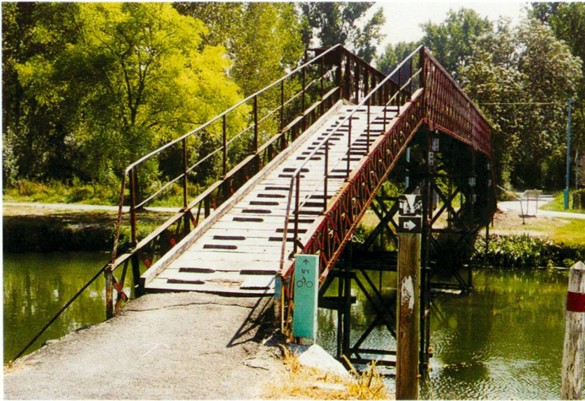
Kleine Stahlbrücke, Architekturtradition der Region.
