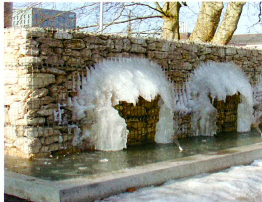
Impressionen zur Steinkorbmauer im Wasserfeld.
