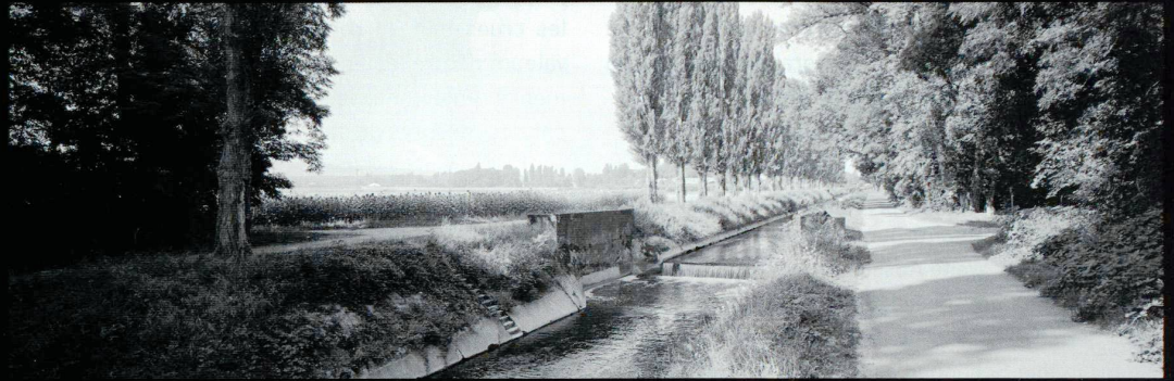
1 Der bestehende Kanal unterhalb von Lully. Le canal existant à l'aval de Lully.
