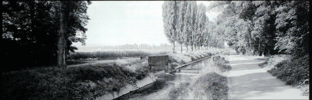
1 Der bestehende Kanal unterhalb von Lully. Le canal existant à l'aval de Lully.
