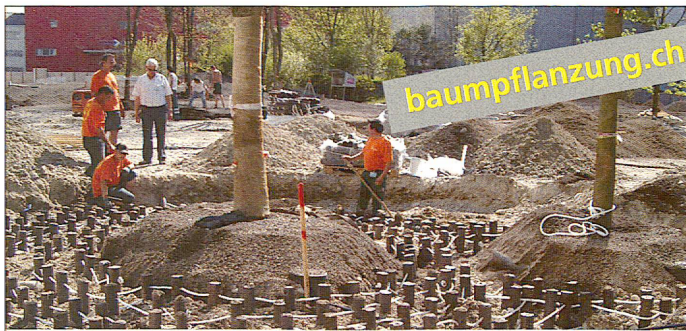
Wurzelanker für Grossbaumpflanzung auf Tiefgarage
