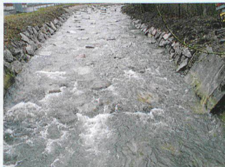
Aufgelöste, unstrukturierte Rampe, 2008.
