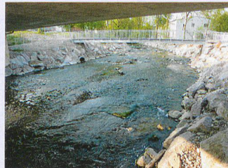
Blockrampe mit neuer Fussgänger- und Velobrücke, 2011.
