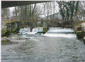
Ehemaliges Wehr mit Mittelpfeiler und Fussgängersteg, 2009.
