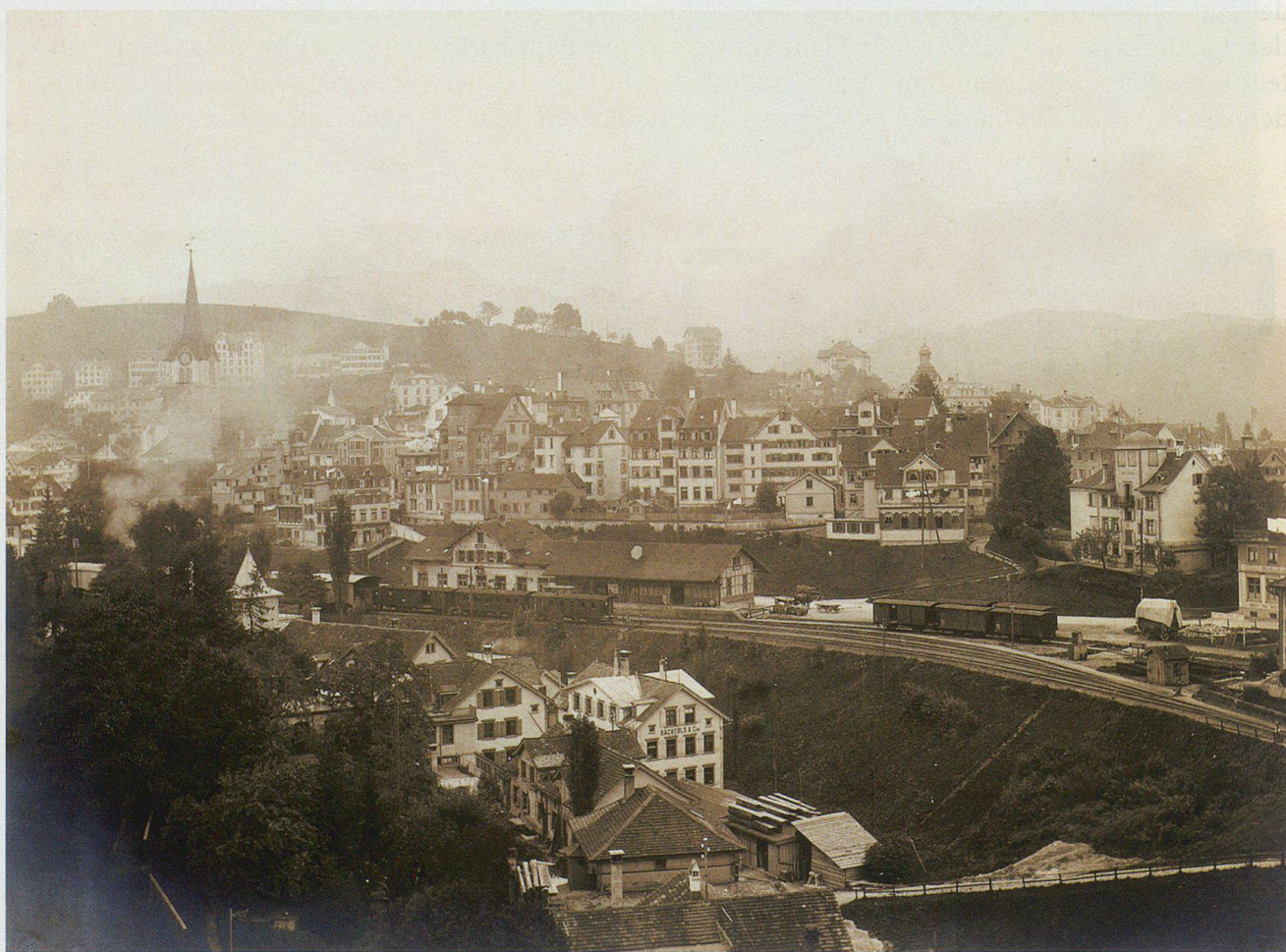
Die Ein- und Ausfahrt in die zentrumsnahe Station Herisau der Appenzeller Bahn geschah über das gleiche, von rechts kommende Gleis. Richtung Urnäsch–Appenzell fahrende Züge wurden zur Abzweigstelle zurückgeschoben.
