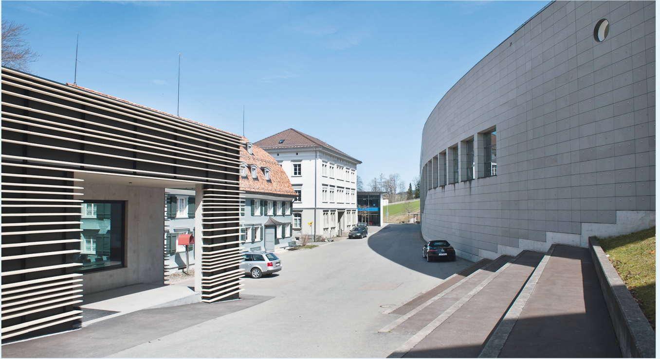
Campus der Kantonsschule Trogen mit dem ältesten Schulgebäude, dem Alten Konvikt, das Alte Schulhaus und der Eingang zur Aula im Hintergrund, das Schulhaus Arche und das neue Entree zur Mensa.
