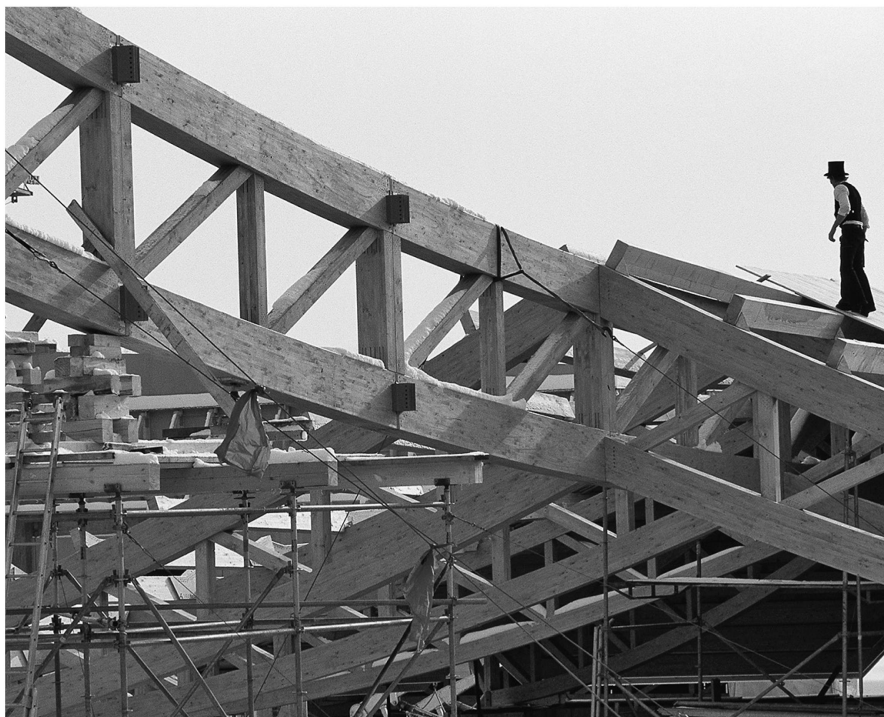
Die BSB-Verbindung kam erstmals beim Bau des Säntisparks in Abtwil zum Tragen.
