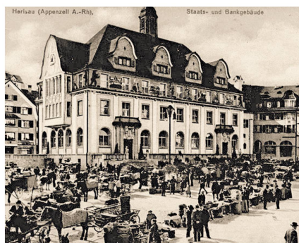
Das fertiggestellte Gebäude 1914 mit belebtem Obstmarkt.
