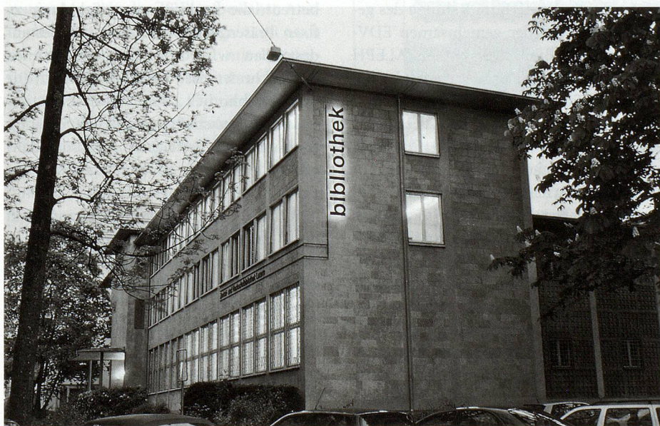
ZHB Luzern, Hauptgebäude, Sempacherstrasse 10.
