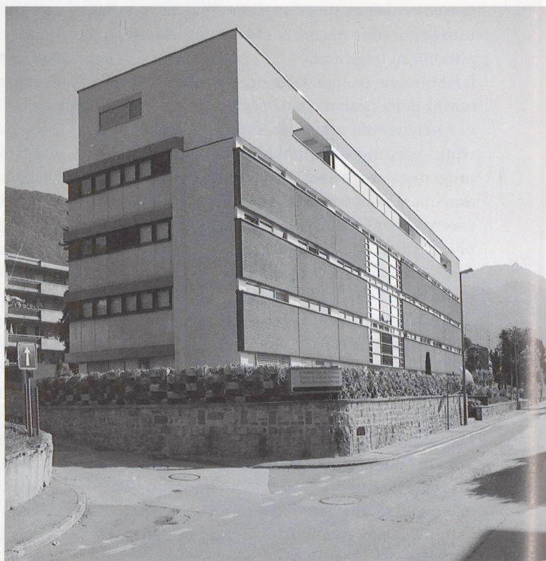
1 — Vista dell'edificio da sud
