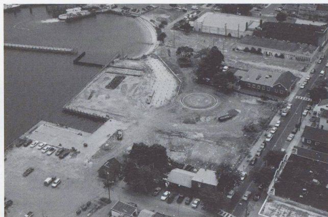
Vista dell'area d'intervento
