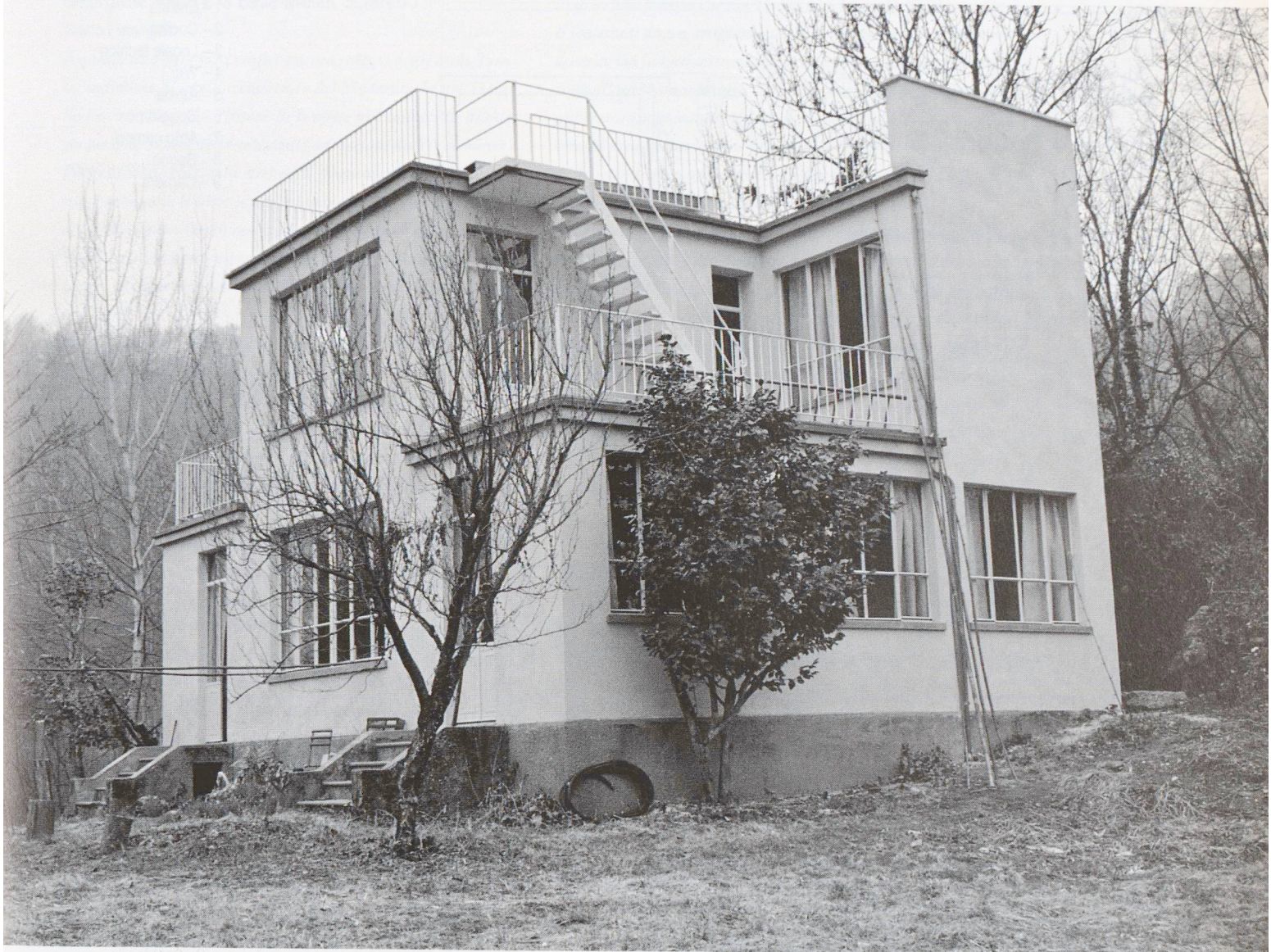
Dopo il restauro, 2000
