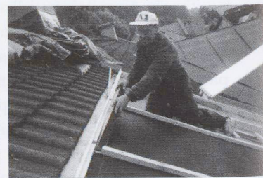
Montaggio di un pannello isolante
