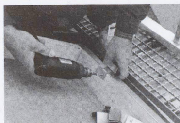
Montaggio dei supporti per il vetro
