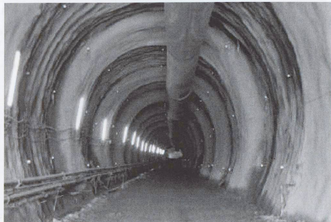
Galleria in materiale sciolto, tubo ovest. Da notare la sagoma «a dente di sega», tipica degli avanzamenti a infilaggi
