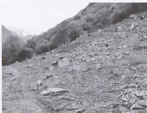
17 - Il disboscamento preliminare consente una valutazione realistica delle dimensioni dei blocchi costituenti il terreno di costruzione. I portali delle due canne ovest (a sinistra) debbono essere collocati circa al centro della fotografia
