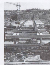
5 – Vista frontale dell'avanzamento Ponte-Passerella
