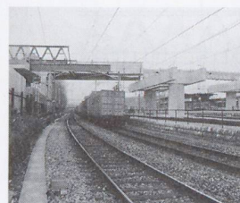
4 – Fase di spostamento del ponte con vista parziale dei tralicci temporanei di acciaio, dell'avambecco e dei pilastri con testa a martello
