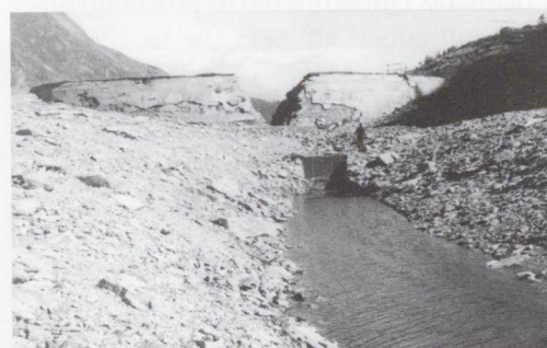
15 - Diga messa fuori servizio con la formazione di una breccia
