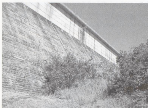
5 - Diga di Uruguay-I in Argentina, realizzata in calcestruzzo rullato
