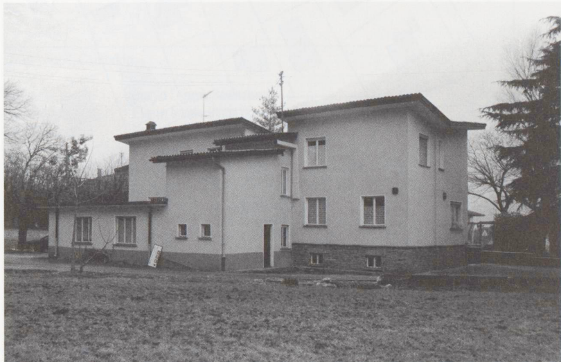
Il fronte posteriore, nella situazione preesistente
