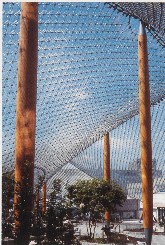
Fig. 4 – Copertura a struttura reticolare in cavi a Bad Neustadt e rivestimento con assicelle in vetro.
