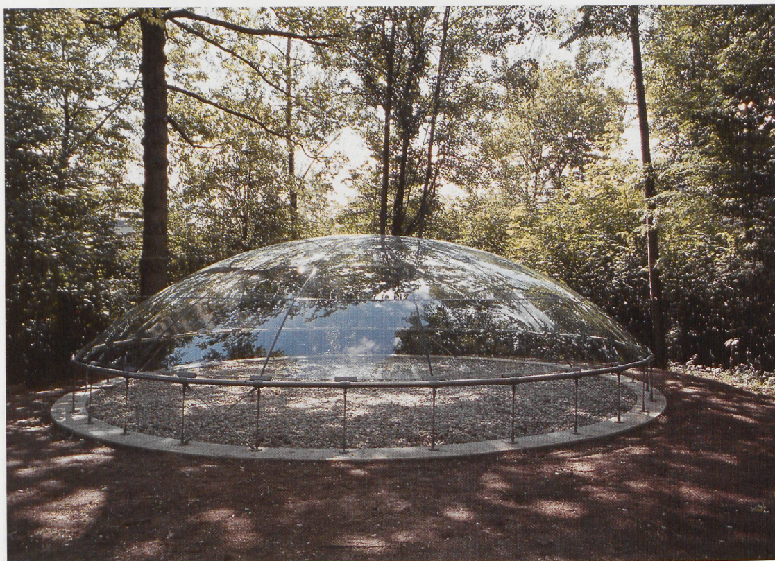
Fig. 11 – Glass Shell nr.2, con una campata di 8.5m
