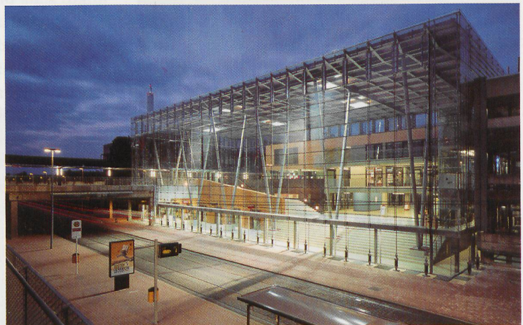
Fig. 7 – Facciata in vetro a cavi paralleli all'Università di Bremen
