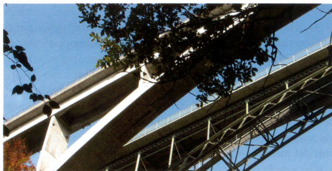
Ponte di Schwarzwasser (BE): costruito nel 1882, il ponte presenta un arco in acciaio con una campata di 120 metri, realizzata mediante chiodatura. Nel 2005 la corsia ferroviaria è stata ampliata e ristrutturata con elementi prefabbricati in cemento armato.
