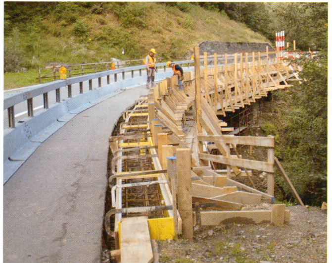
Intervento di manutenzione. Rifacimento cordolo
