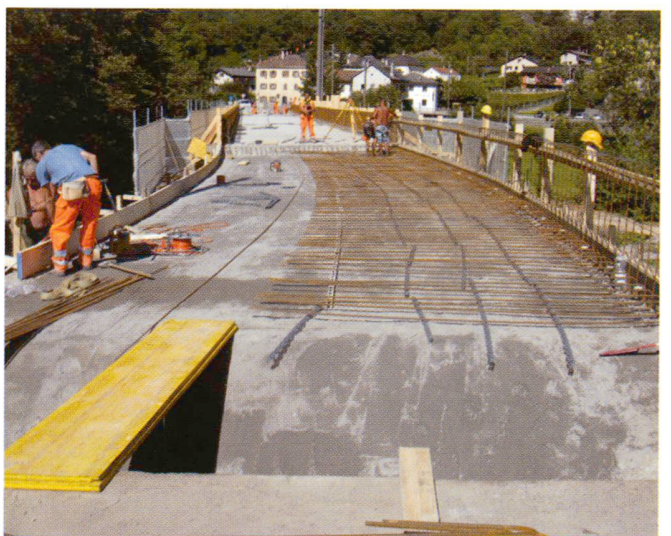
Intervento conservazione. Restauro conservativo
