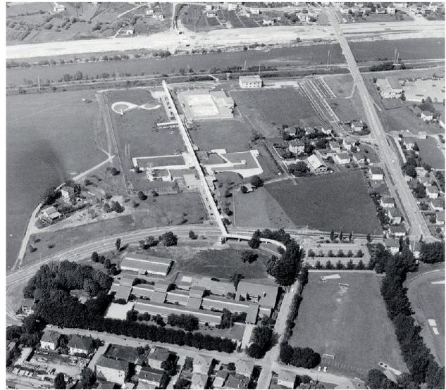
1. Aurelio Galfetti, Flora Ruchat e Ivo Trümpy, foto aerea Bagno pubblico comunale, Bellinzona, 1967-1970. Foto archivio privato Aurelio Galfetti, Lugano
