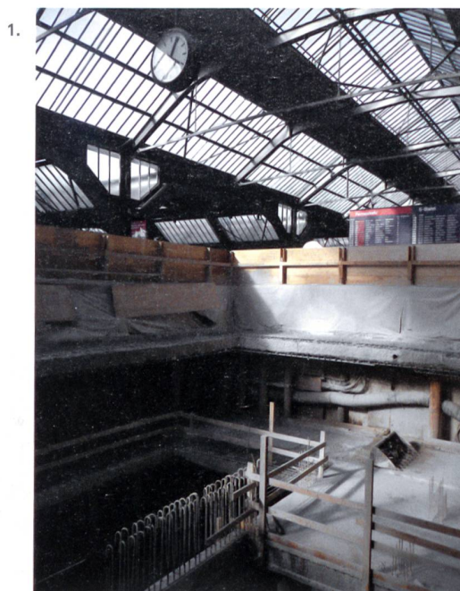
1. Straordinaria opera ingegneristica: Passante di Zurigo, costruito nel cuore della città, senza interrompere il traffico ferroviario. Foto Judit Solt
