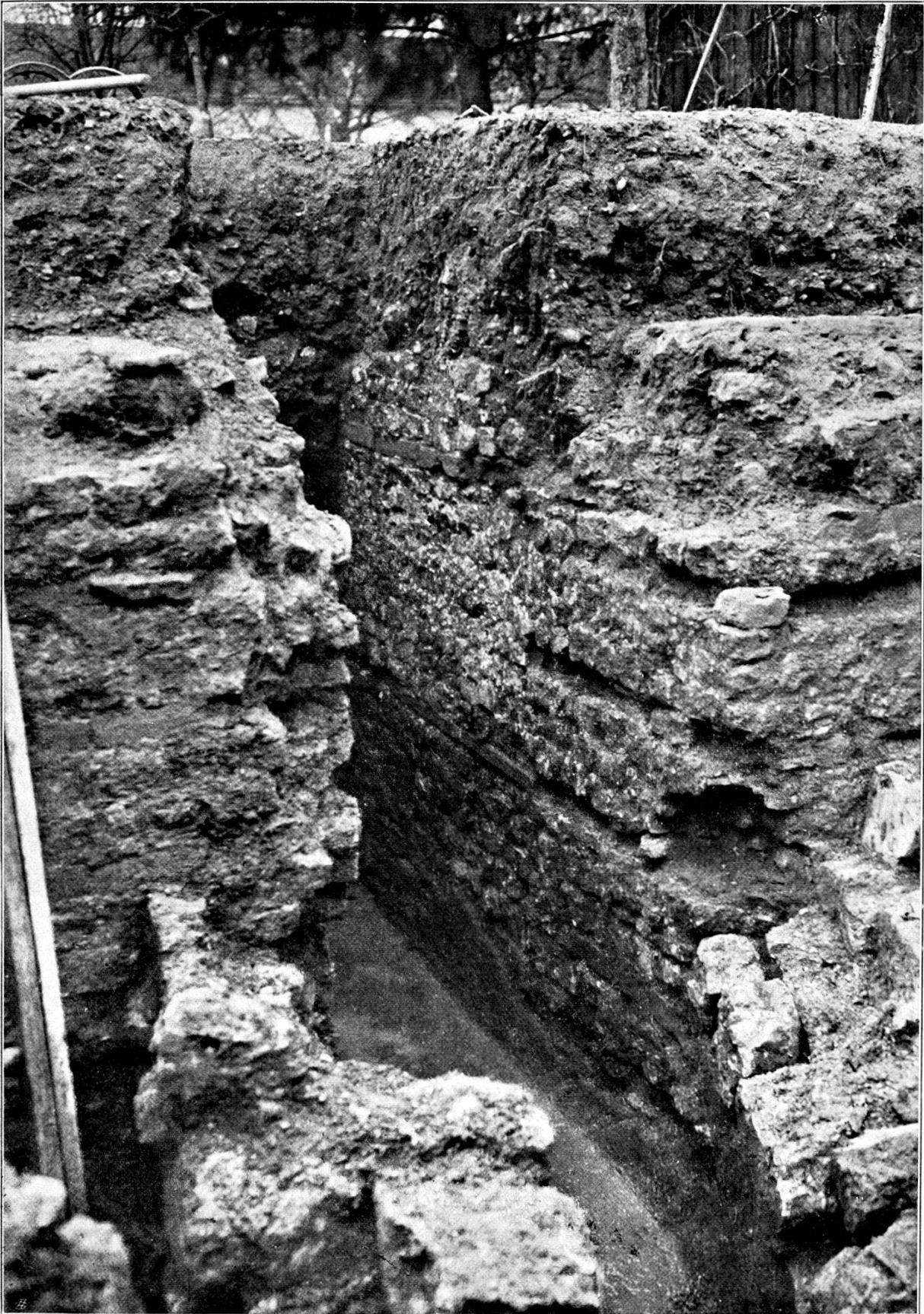
Der große Süd-Nordkanal, bei der Einmündung in die Wasserkammer, mit angebaute mittelalterlicher Fortsetzung (im Vordergrund). Aufnahme 1907.
