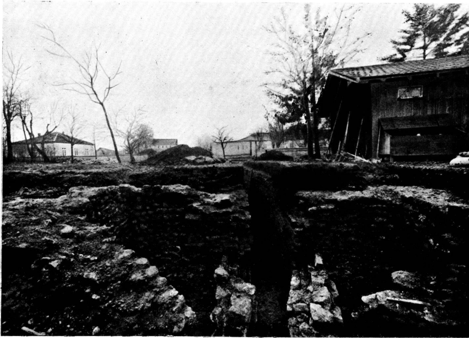
Der große Süd-Nordkanal bei der Einmündung in die Wasserkammer, mit der angebauten mittelalterlichen Fortsetzung (des römischen Kanals). 1907.
