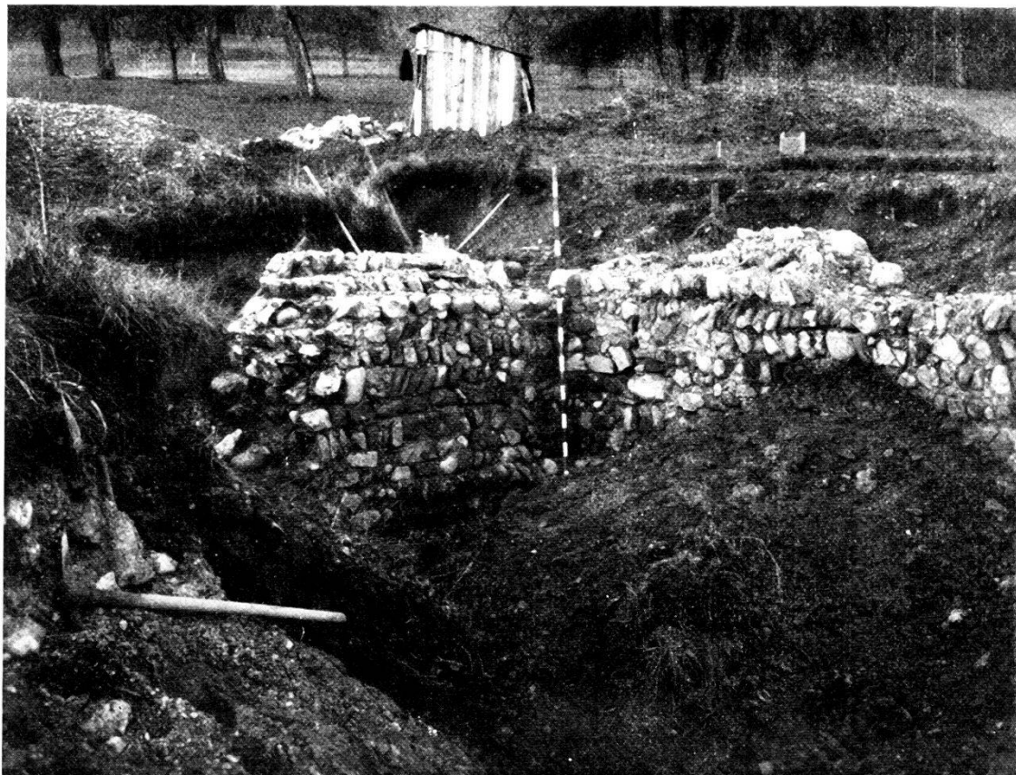
Abb. 5. Mauerwerk des Palas.
