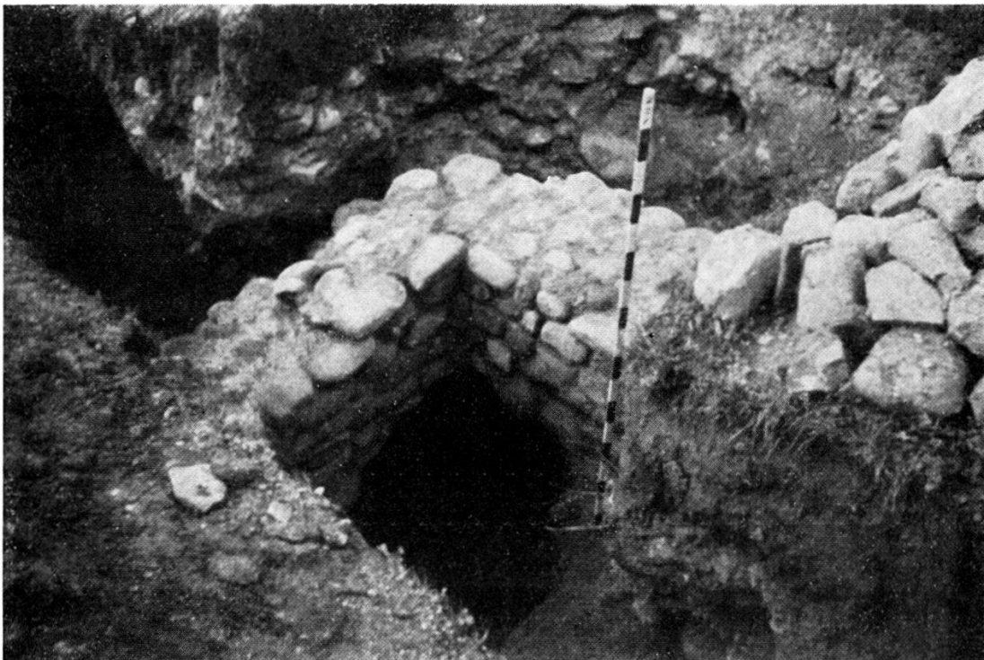
Abb. 8. Nordostecke des römischen Ökonomiegebäudes von Kirchdorf, von innen.
