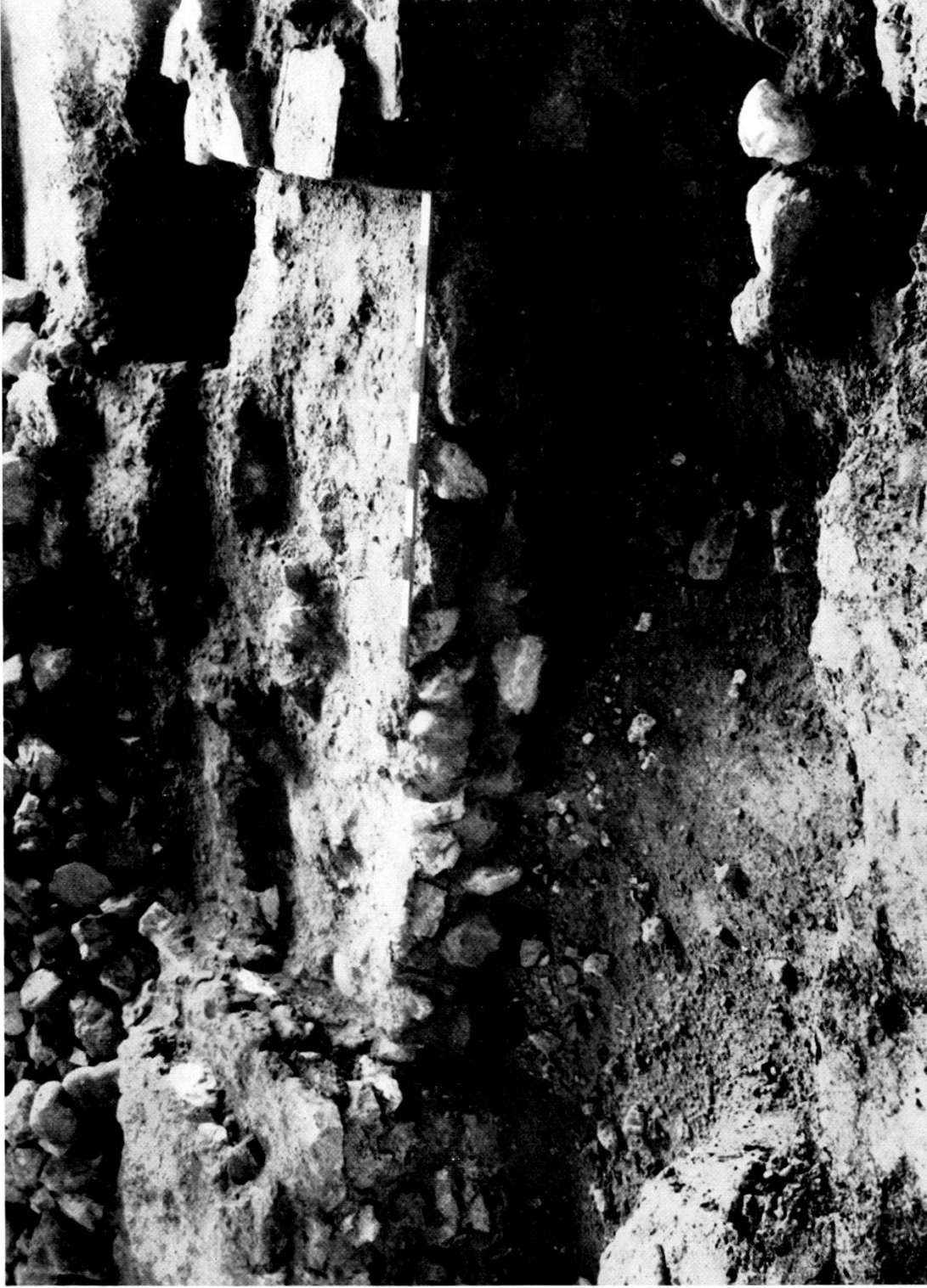
3 Toranlage in der romanischen Südmauer
