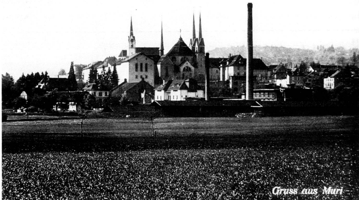
Ziegel- und Backsteinfabrik mit den beiden Hochkaminen. Heute als Lager verwendet
