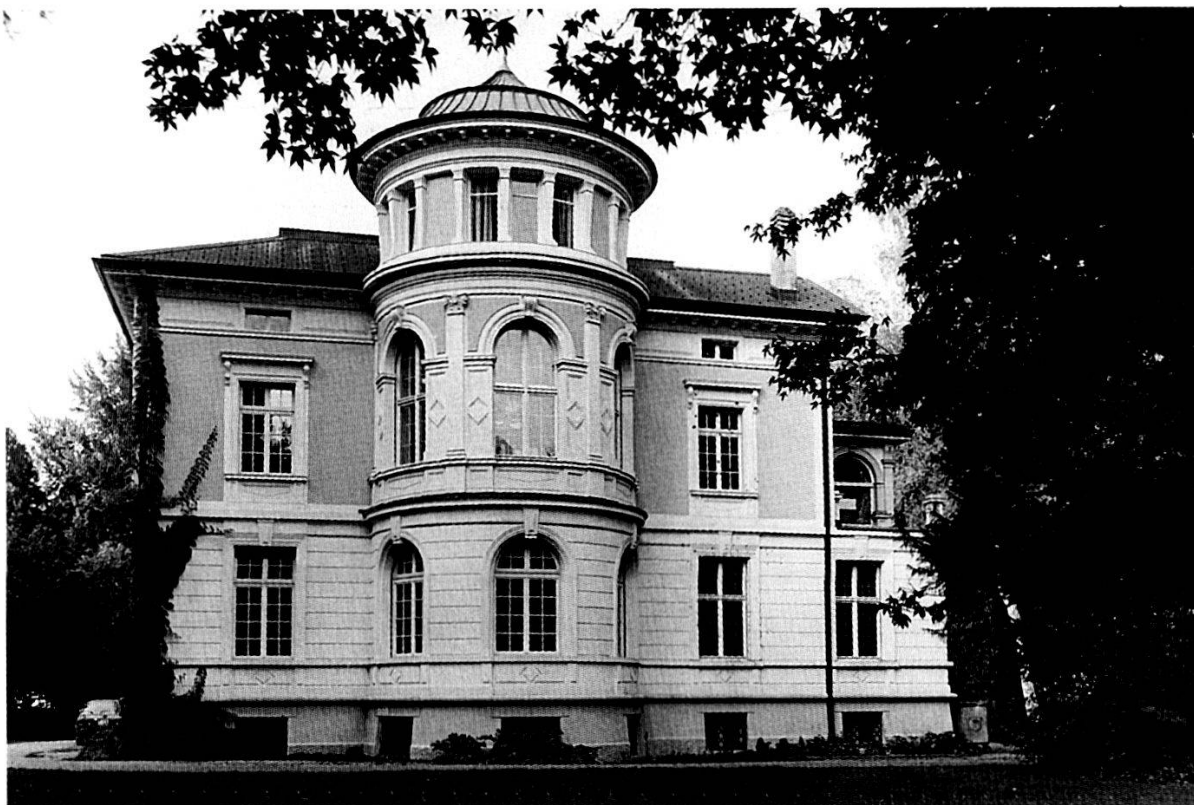
Abb. 10: Im Francke-Gut – hier eine Ansicht der Rückseite – war bis zu ihrer Auflösung auch die Vorbereitungsstufe der Hochschule Aargau angesiedelt.
