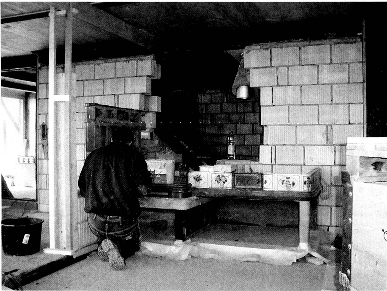
Wiederaufbau des Kachelofens in der «Alten Mühle» Auw (Bild Haupt Architekten, Ruswil).
